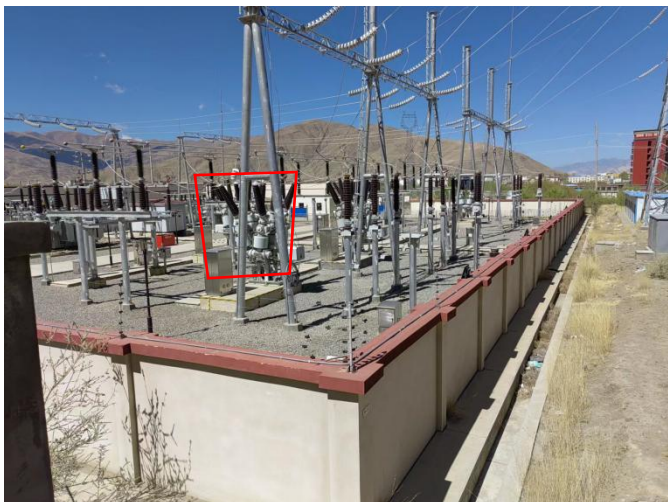
变电站扩建 1 回 110kV 出线间隔
